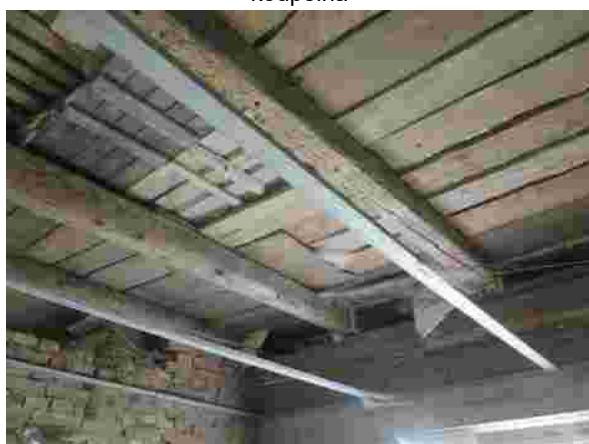
nedokončená část elektrika
